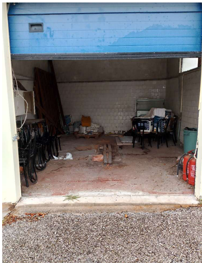
FOTO 5: INTERNO DEPOSITO LATO EST
