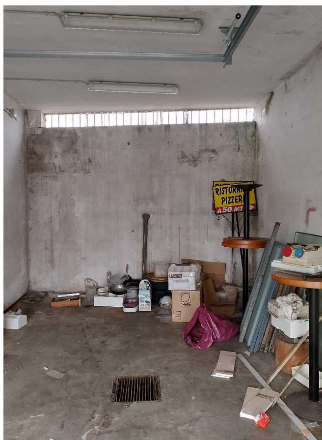
FOTO 6: INTERNO DEPOSITO LATO OVEST
